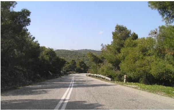
Σχήμα 1. Τυπική άποψη της εξεταζόμενης οδού (χλμ. 17,0).
